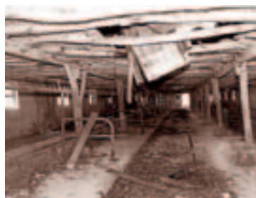
Zustand der Stallungen kurz nach dem Erwerb 2003
